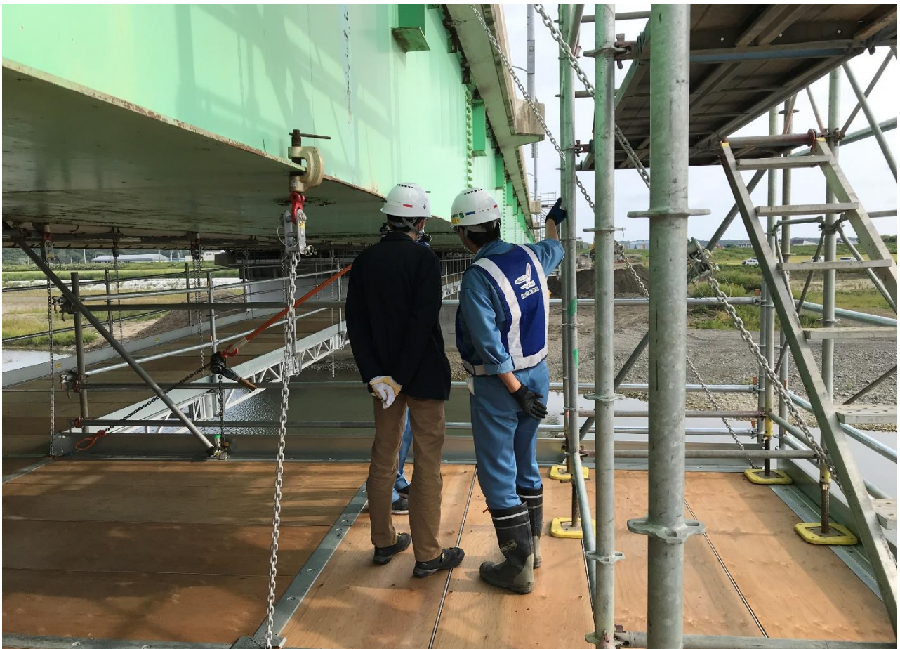
「一般国道235号日高町沙流川橋耐震補強工事」現場見学
