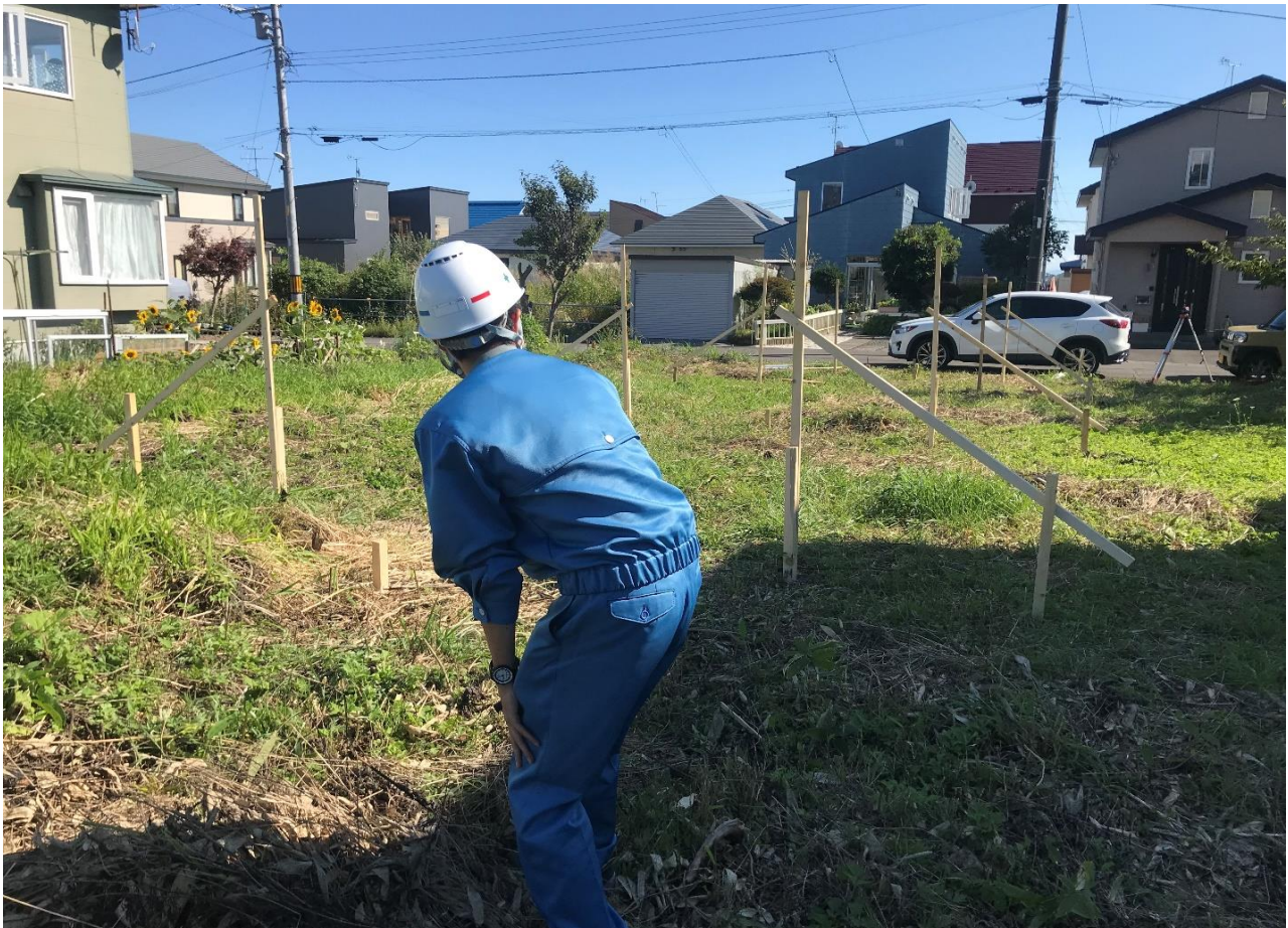
施工図をもとに測量（丁張）実習
